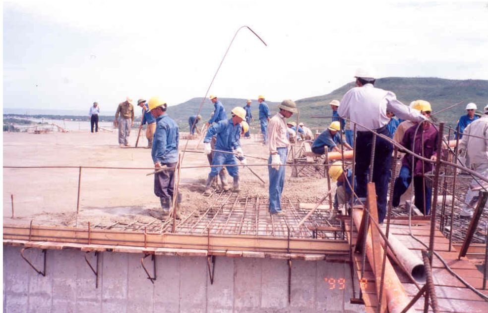
Hình 2.5. Đổ và đầm bê tông bơm
