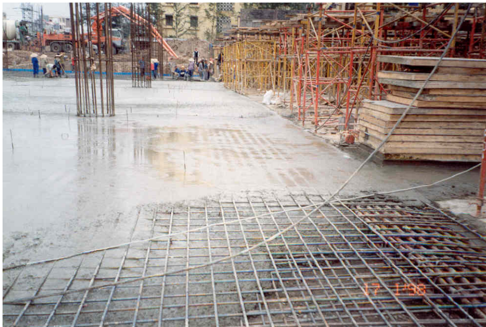
Hình 2.3. Thi công bơm bê tông đổ bê tông sàn
