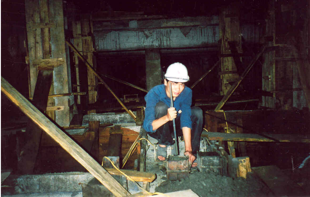
Hình 2.6. Lấy mẫu kiểm tra chất lượng bê tông hiện trường
