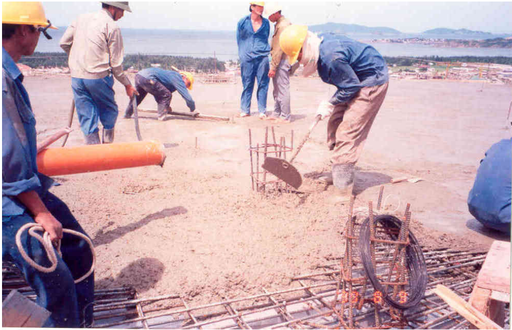
Hình 2.4. Thi công bê tông bơm
