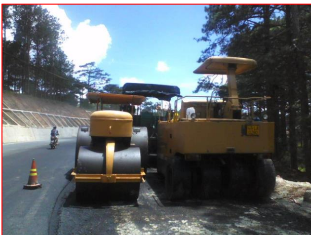
Thi công phải có ít nhất đủ 3 lu: Lu con 2 bánh, lu lóp và lu 3 bánh bảo dưỡng
