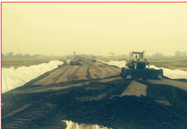
Đắp cát nền đường
