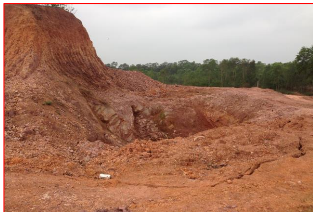
San đắp nền đường
