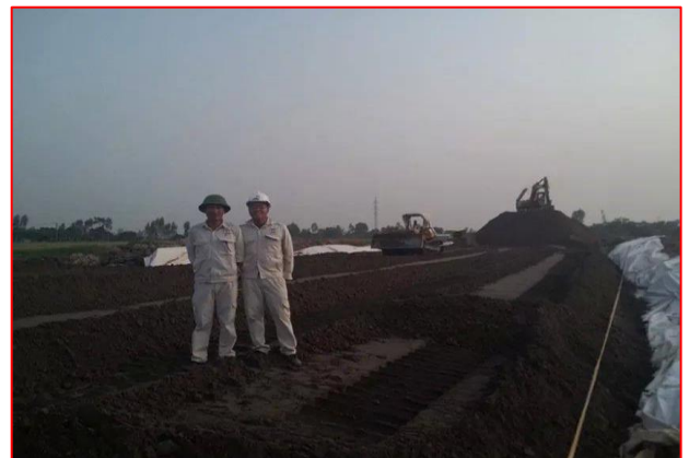
San đắp nền đường
