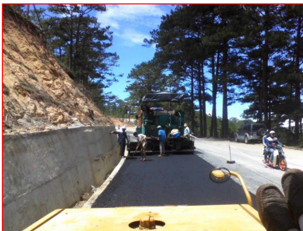
Rải thảm mặt đường
